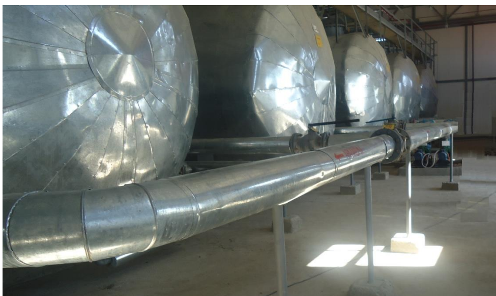
Рисунок 6 – Биогазовый завод суточный дозой загрузки биомассы 25 т/сут. (влажностью 94\pm 2\% ). Карулбазарский район, Бухарской области
