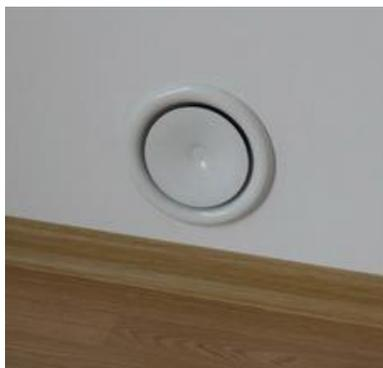
Рисунок 11 - Диффузор, равномерно распределяющий потоки на выходе из воздуховода
