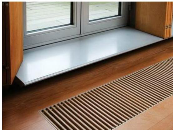
Рисунок 3 - Напольное воздушное отопление
